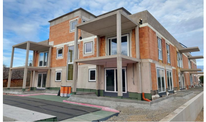
MAUTERN - ROHBAU EIGENTUMSWOHNUNGEN
