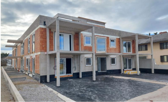
MAUTERN - ROHBAU EIGENTUMSWOHNUNGEN
